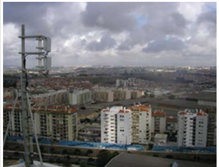
Antenas de Estación Base en el tejado de un edificio en Lisboa (Portugal).
