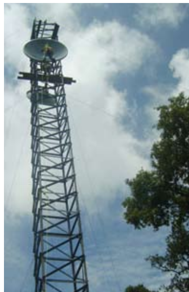
Los técnicos del sistema instalando una de las dos antenas en el repetidor.
